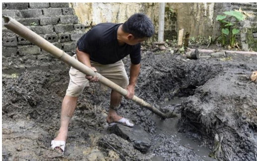
工廠掩埋地下管線，將未處理廢水排放至馬江。
